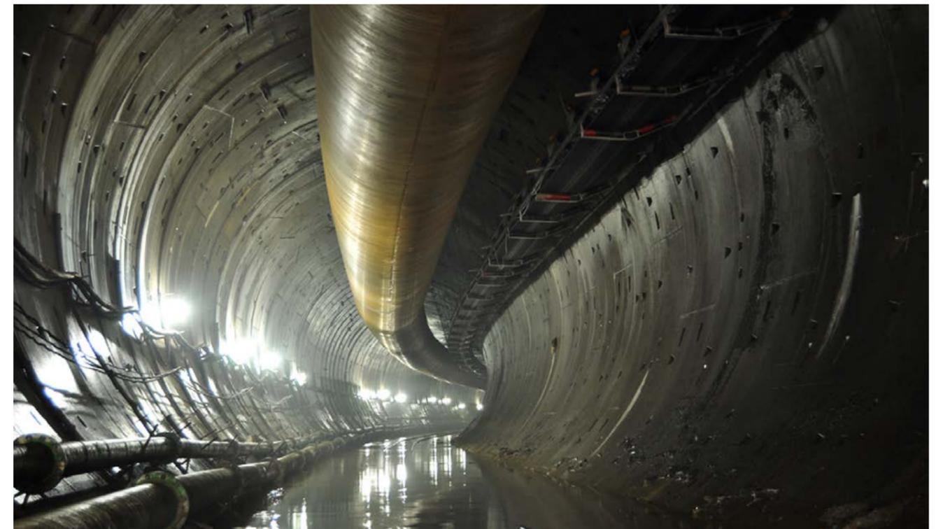
Figura 12.- Túnel de conducción con dovelas
