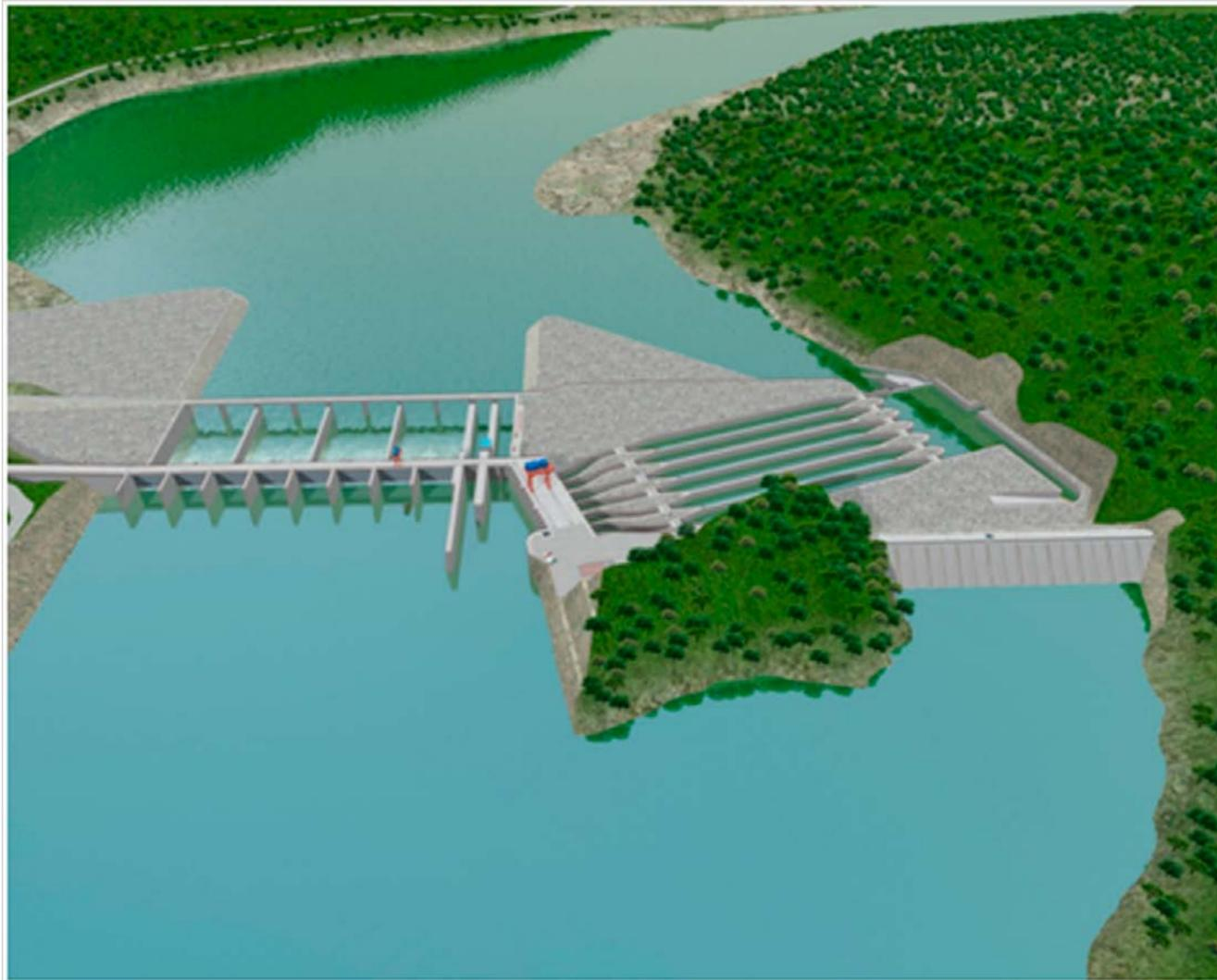
Figura 10.- Vista 3D de la obra de Captación – vista aguas arriba
